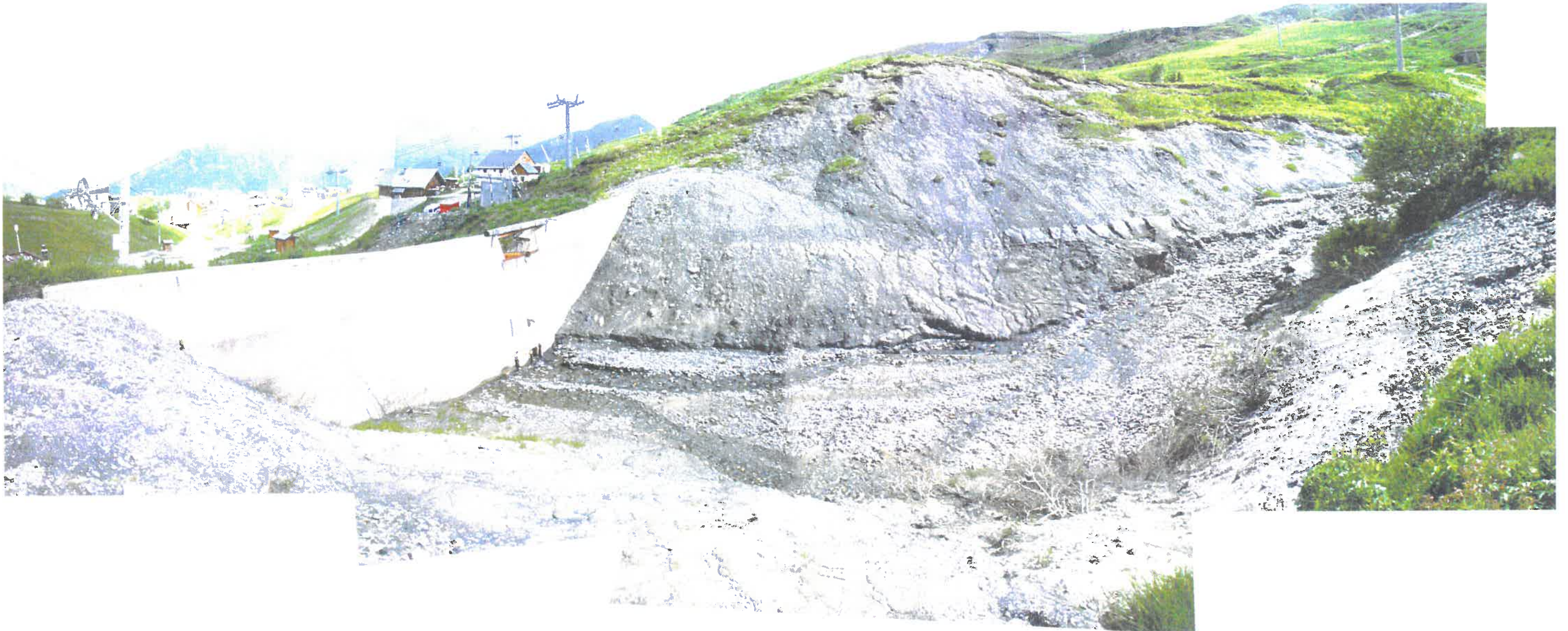
Photo 1. : Vue d'ensemble du barrage de l'Edioulaz.
