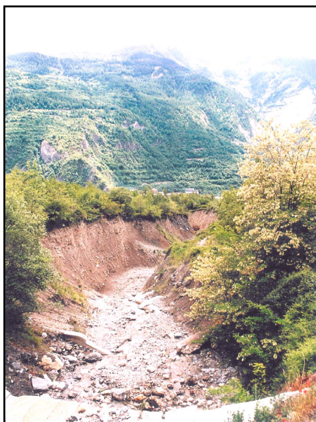
Berges du torrent du Claret dans la partie amont du cône de déjection (amont du pont de la Raie)
