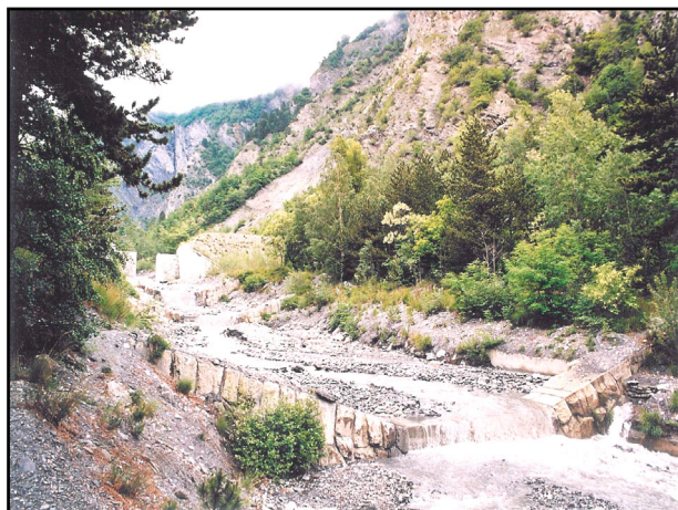
Plage de dépôts et seuils du torrent de Saint-Julien
